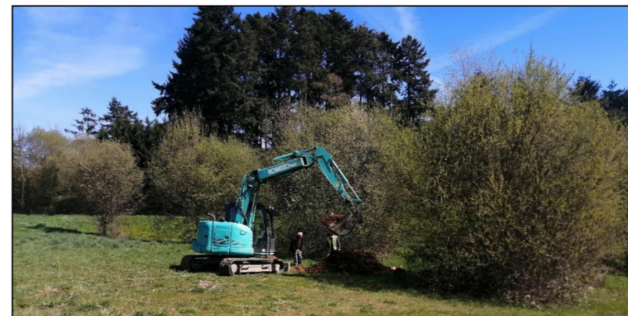
Photographie 10: Sondages géotechniques en vue d'étudier des fondations-pieux non impactantes (Source : ENCIS Environnement)
