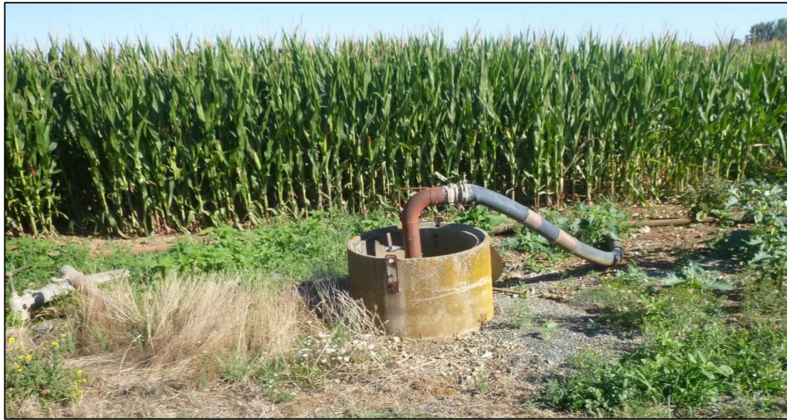
Photographie 8 : Petit forage destiné à l'irrigation au sein de l'AEI (Source : ENCIS Environnement)
