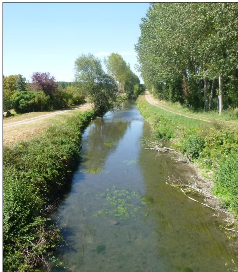
Photographie 1 : Canal de la Dive, à l'est de l'AER (Source : ENCIS Environnement)
