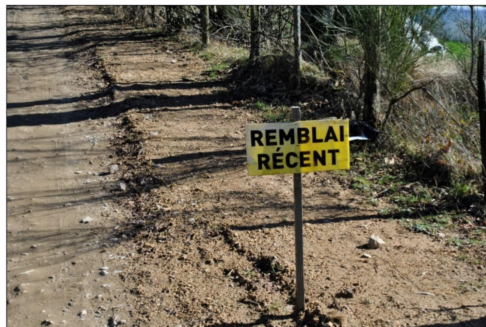
Photographie 9 : Exemple de remblai des tranchées électriques le long d'une piste (Source : ENCIS Environnement)
